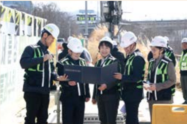
탄천변 동축도로 구조개선사업(1구간) 건설 공사 현장방문
